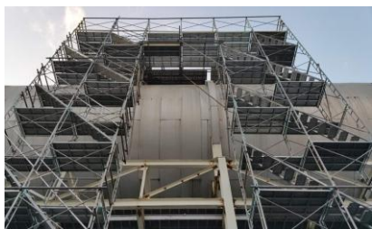
枠組足場工事
