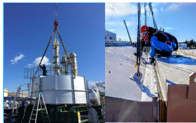
重量物据付工事
