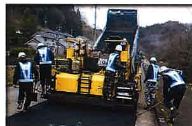
舗装作業の様子
