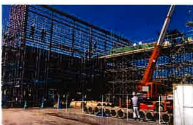
新築現場の次世代足場の様子
