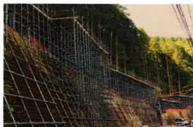
法面アンカー足場の様子
