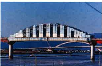
橋梁補修用吊り足場の様子
