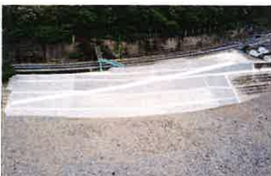
河川工事完成の様子
