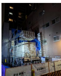
発電機本体の搬入 組み立て 重量約 20 トン
