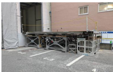
重量に適した搬入ステージ組み立て
