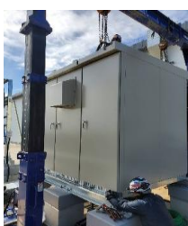
所定の位置まで移動後、 下降させ据付する。
