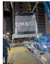
クレーンを使い ステージ上に 発電機本体借り置き
