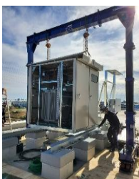
油圧門型リフターを使用して吊り上 げ、所定の位置まで移動する。
