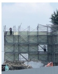
作業中の様子
