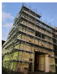
作業現場風景
