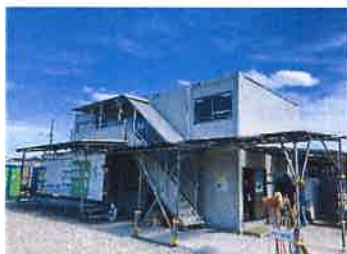
「現場事務所（外観）」
