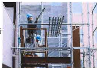
「足場の組立作業」
