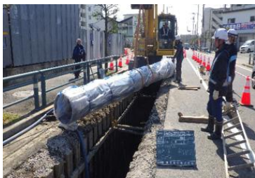
水道管を埋設しています。
