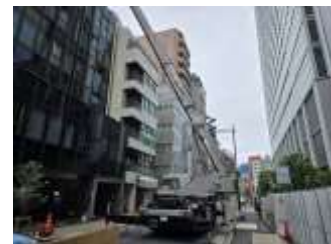
重量物を屋上に設置です。
