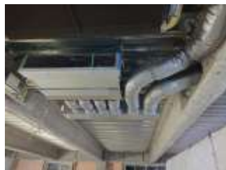
ビルの天井内空調機設置工事
