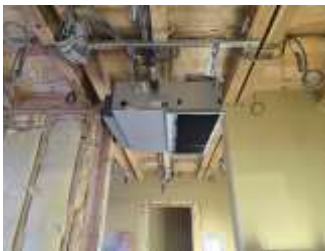
空調機設置工事中です。
